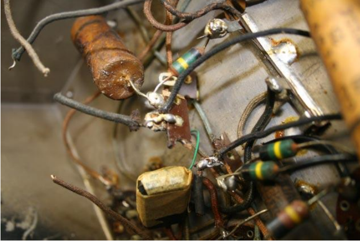
Broken Lug Strip
