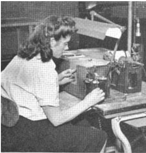
Pliage des filaments avant leur insertion dans les manchons des cathodes.
