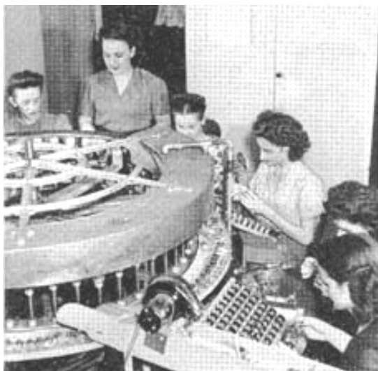
Assemblage des bases scellées aux broches de contacts.
