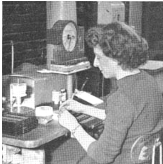
Vaporisation du manchon de la cathode avec un mélange de carbonate qui permettra l'émission d'électron.
