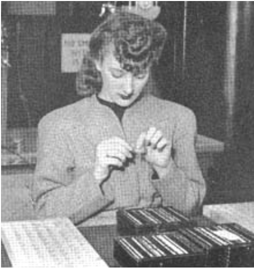
Insertion des filaments pliés dans les manchons des cathodes. Cette opération exige une très grande dextérité.
