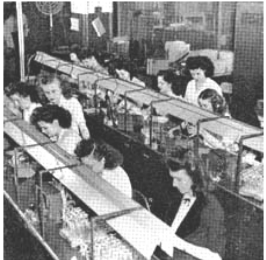
Ce groupe fait le montage des cathodes, grilles, plaques et autres pièces sur les tiges.
