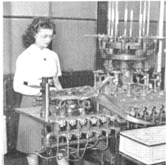
Opération de l'évaseuse, qui scelle les fils de connections des électrodes dans une tige de verre.
